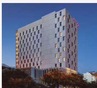
Hotel Moxy Oriente. Hotel. Lisboa, Portugal. PACi, VRF and Control.
